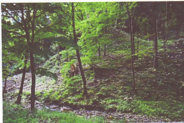
Die Reste des Dammes des Kupferroser Teiches sind noch deutlich zu erkennen
